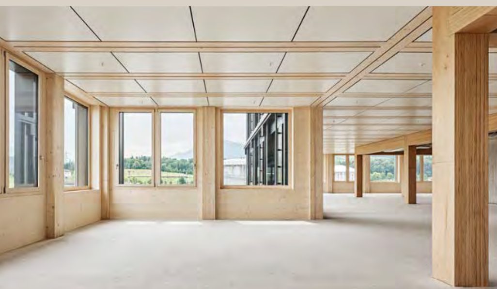
La construction hybride en bois de l'immeuble de bureaux Suurstoffi 22 à Rotkreuz.
