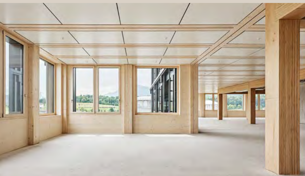
La struttura ibrida del centro uffici Suurstoffi 22 a Rotkreuz.
