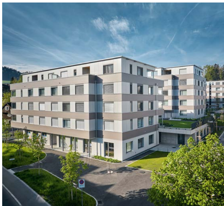
CAMOUFLÉ. La construction à ossature bois se trouve bien protégée des intempéries derrière la façade ventilée en Eternit.
