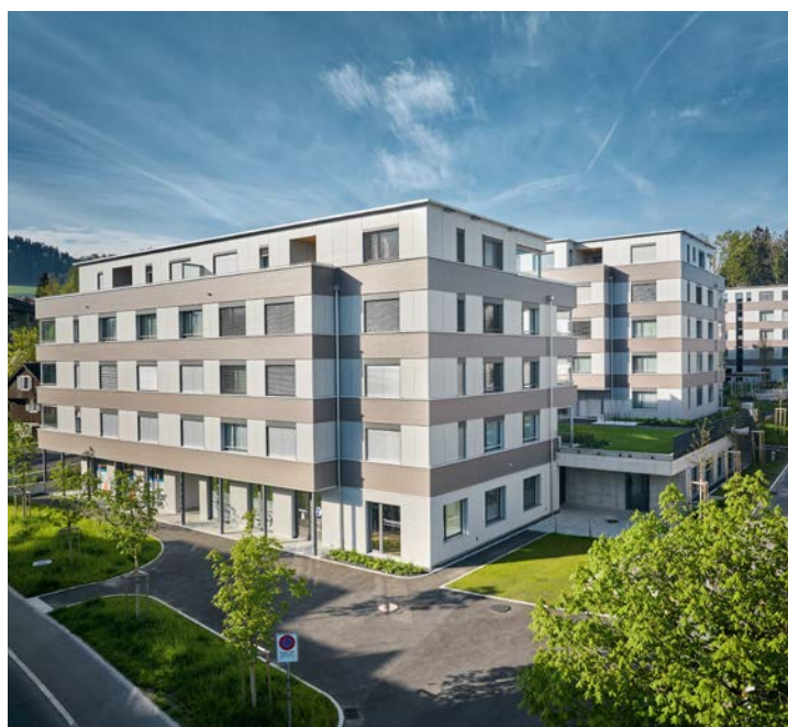
MASCHERATE. Il sistema costruttivo in legno è ben protetto dalle intemperie dietro la facciata retroventilata in Eternit.
