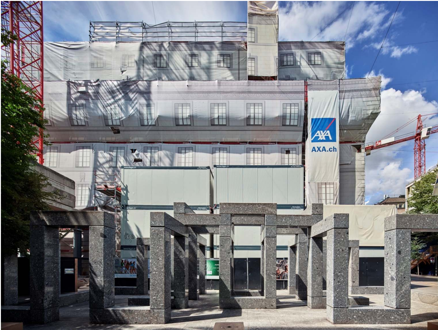
Fotografie: © Luca Zanier
