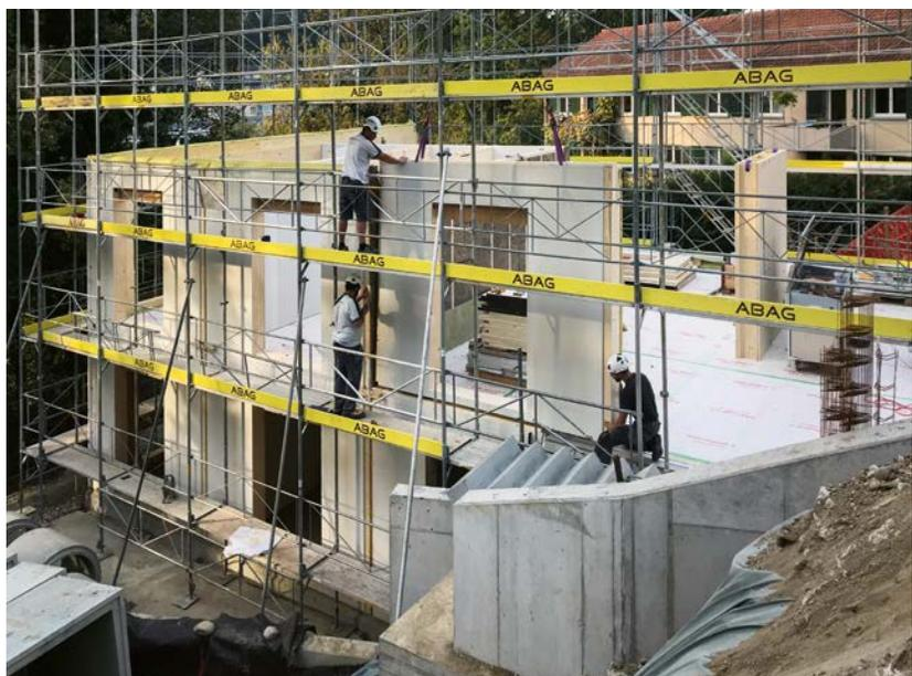
Die vorgefertigten Holzelemente wurden im November 2018 innert 16 Arbeitstagen montiert.
