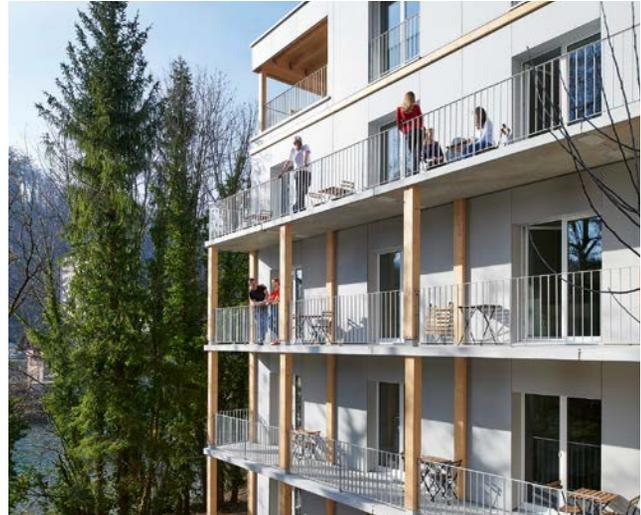
Südseitig sind vor der Holzkonstruktion aus brandschutz-technischen Gründen betonierte Fluchtwege angebaut, die aber auch als Balkone beliebt sind.
