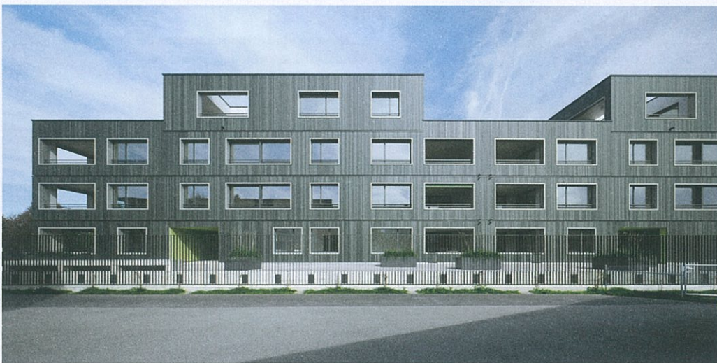
Die horizontalen Linien zwischen den Geschossen deuten an: Dieses Haus besteht aus vorgefertigten Elementen.
