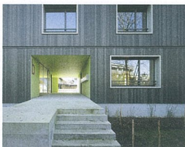
Das Hochparterre schützt das Haus vor Hochwasser.
